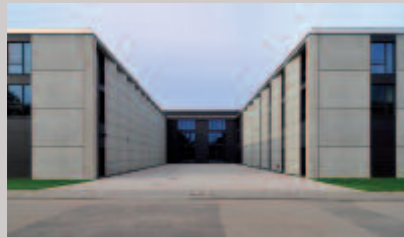
Fasadengestaltung: vertikale Rhythmik aus Fensterstreifen und leicht schräg gestellten Fassadenstreifen (dezent farbig gehaltene Faserzementplatten). Die „Klaviatur“ symbolisiert das musikalische Innenleben
