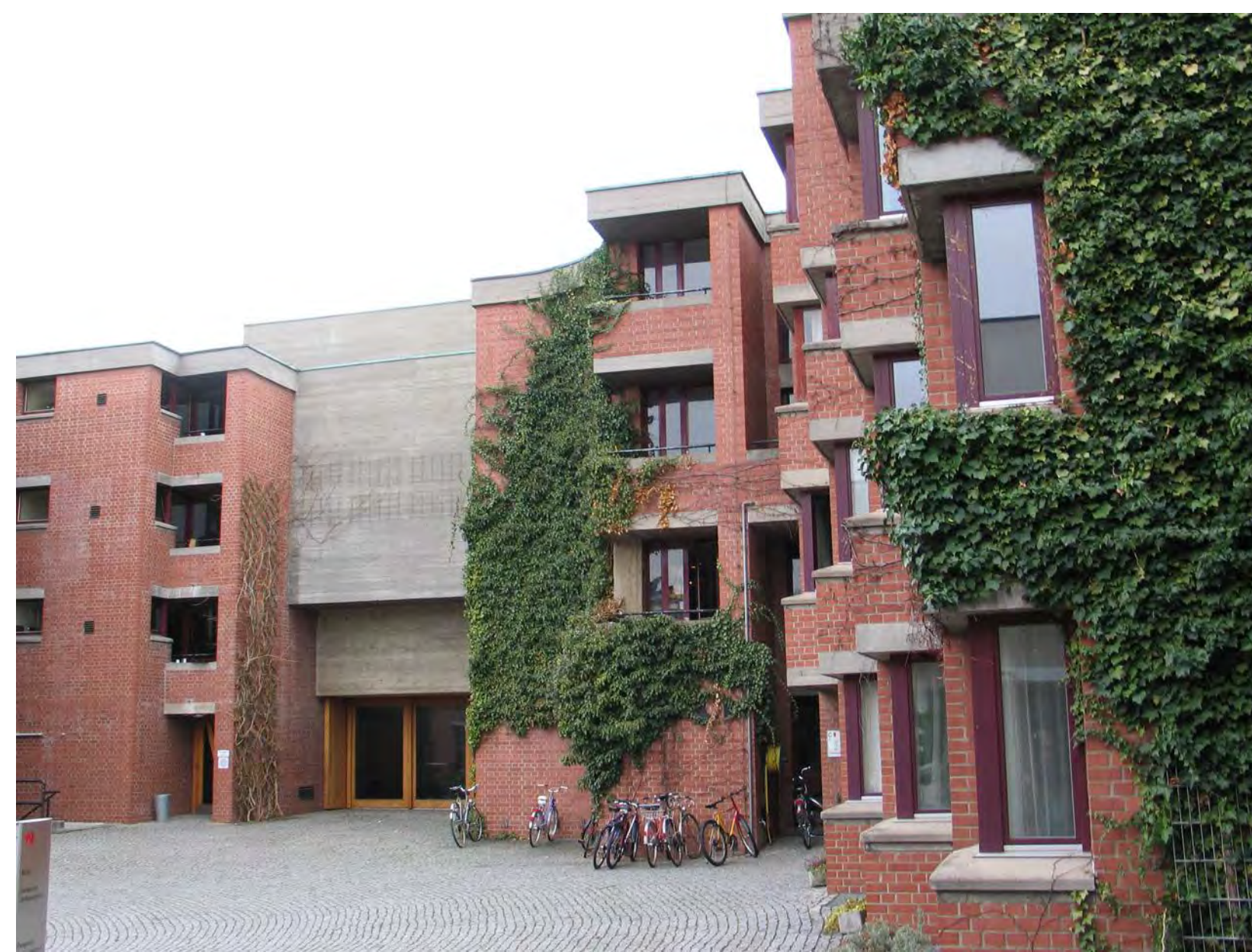
Der Blick vom Innenhof nach Norden verdeutlicht die zelluläre Struktur der Wohntrakte.
