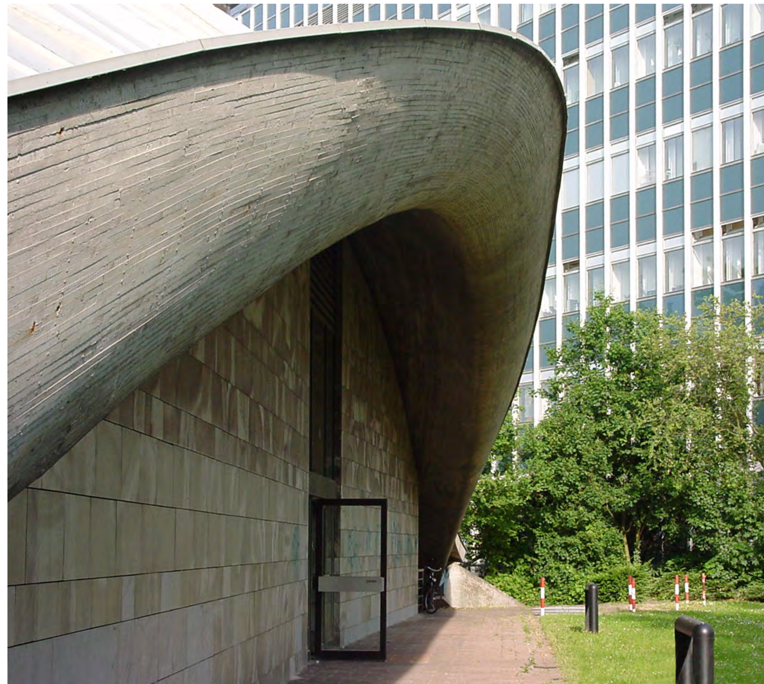
Bild oben: Fassadenansicht Süd-Westen
