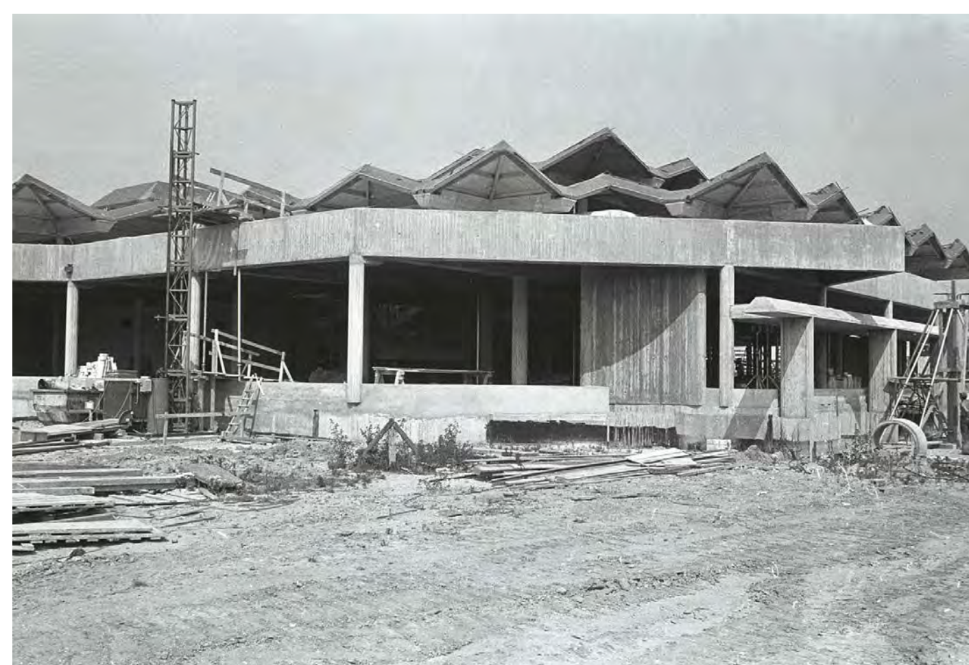
Der Rohbau zur Zeit des Richtfestes 1982, noch ohne Verglasung
