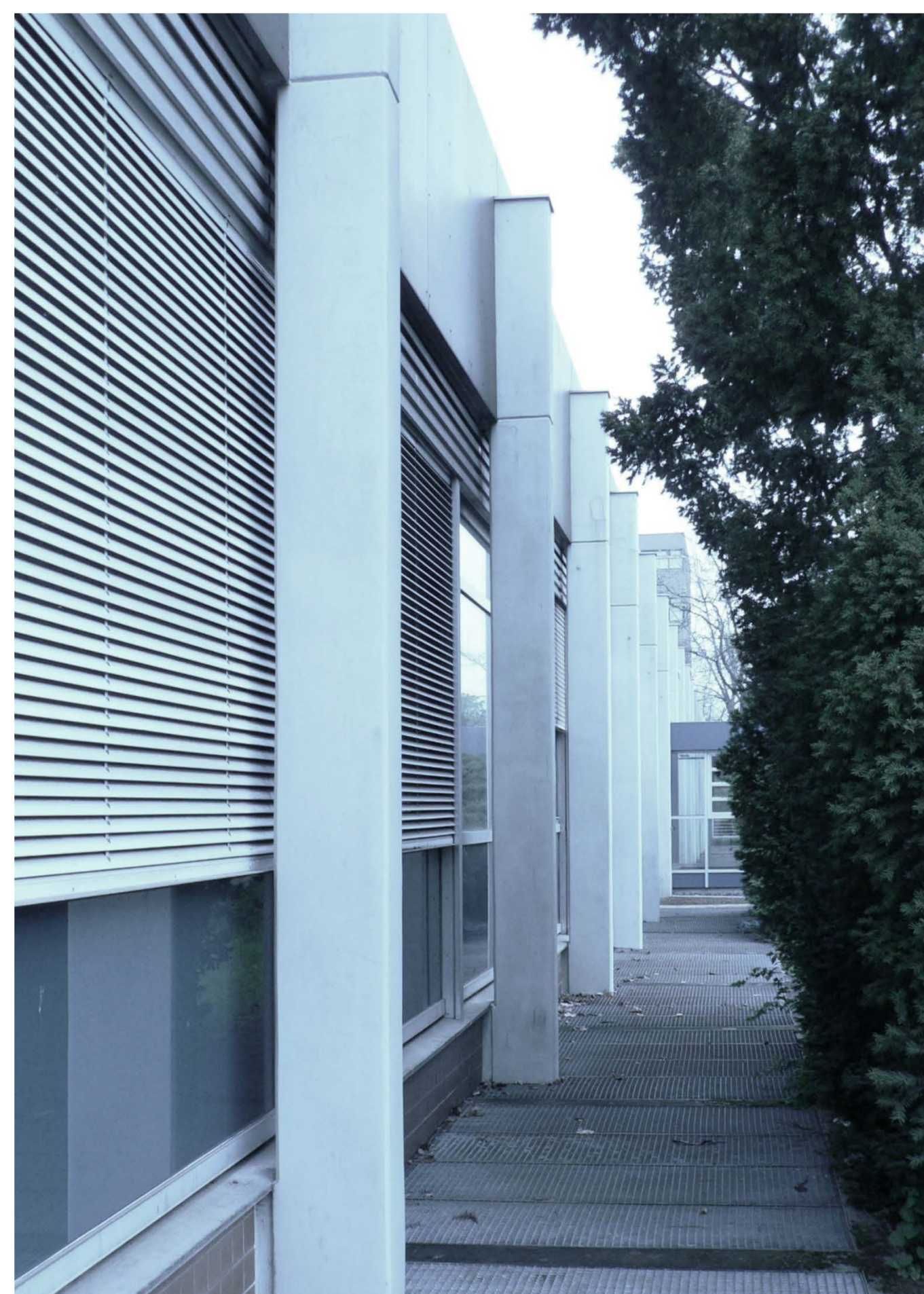
Fassadenflucht des Gebäudeanbaus
