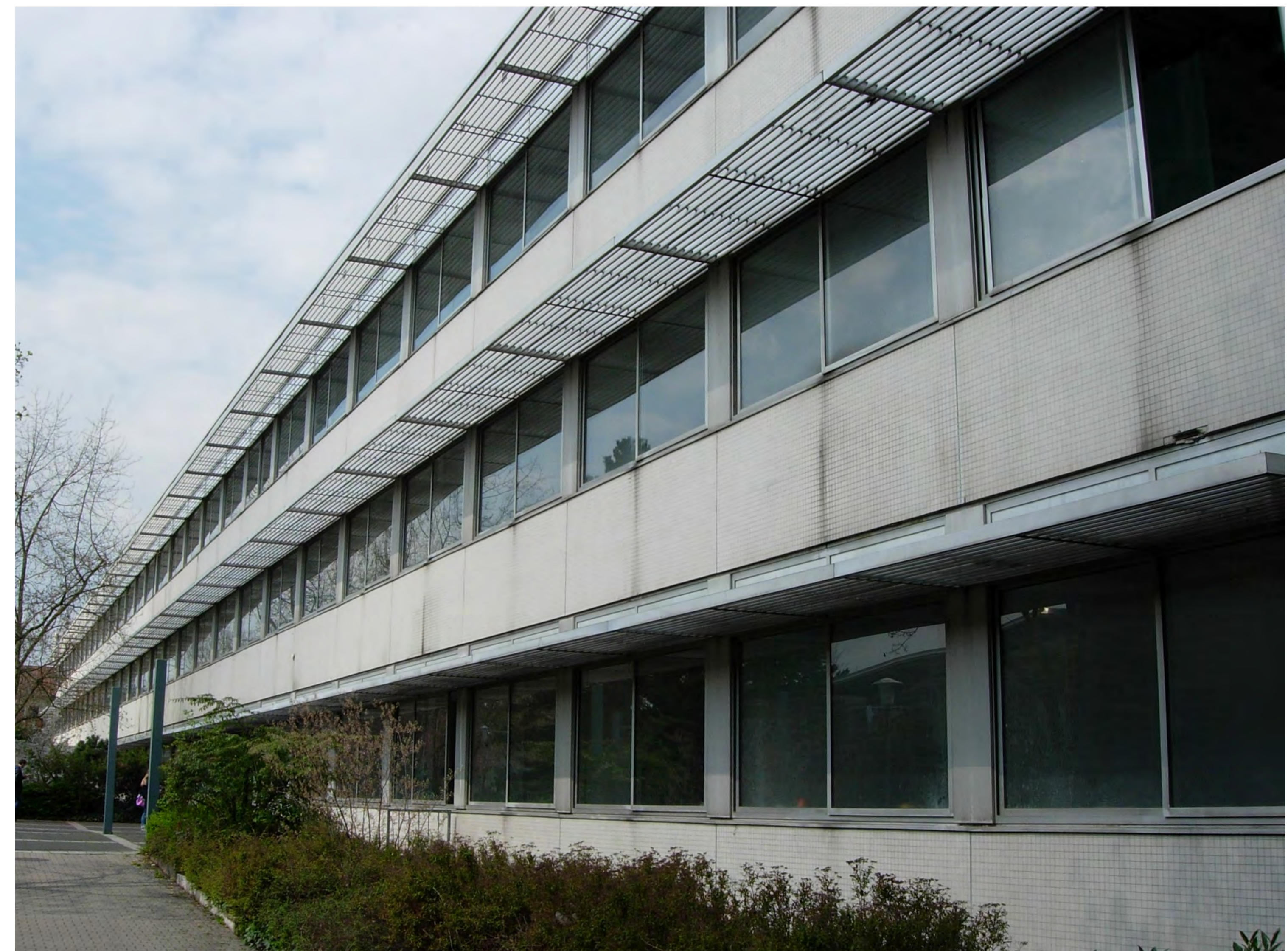
Hinter der Südfassade des Hauptgebäudes mit ihren Bandfenstern und durchlaufenden Sonnenschutzelementen befinden sich hauptsächlich die Seminarräume
