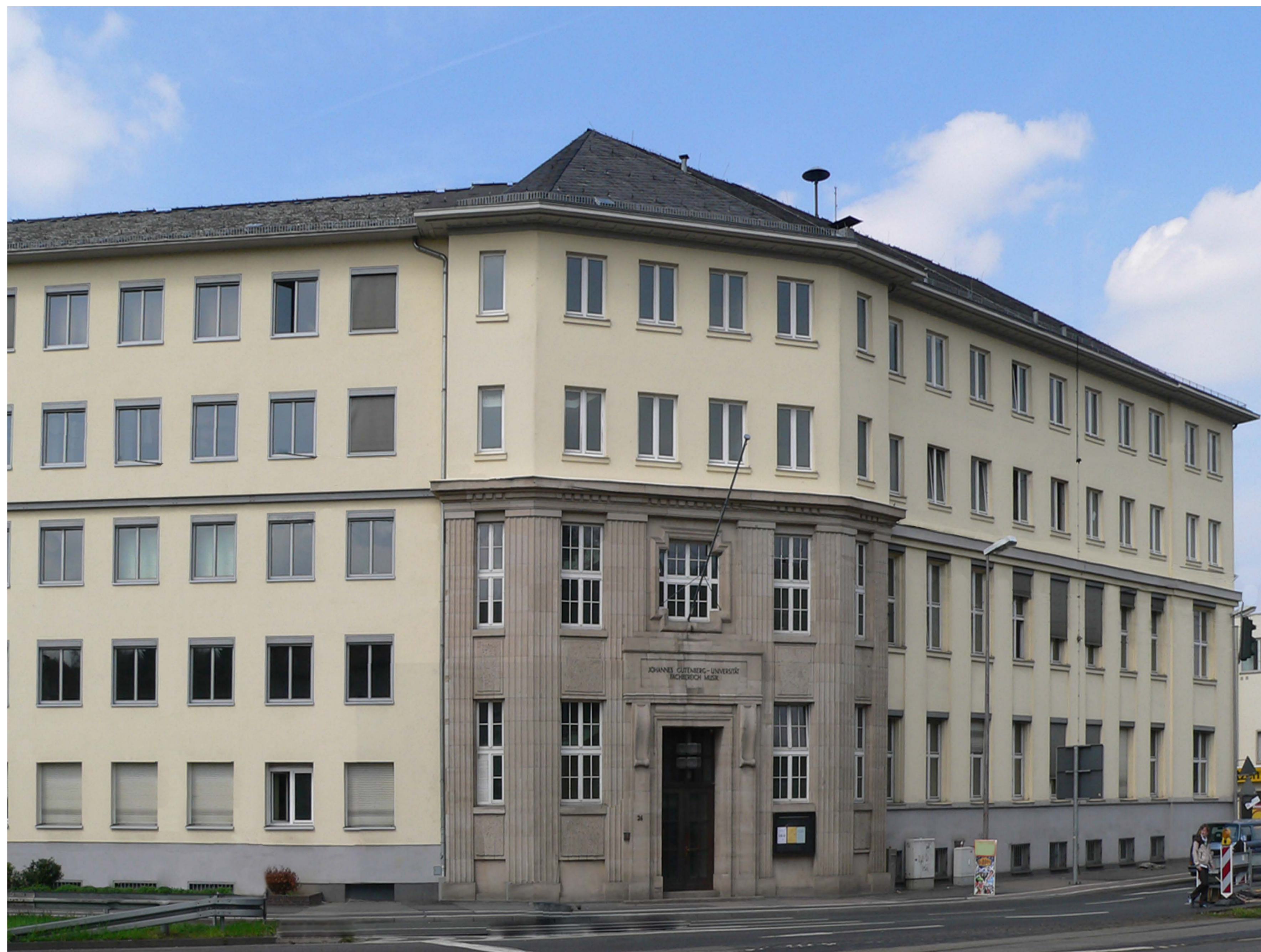
Straßenansicht des Gebäudes Binger Straße 26
