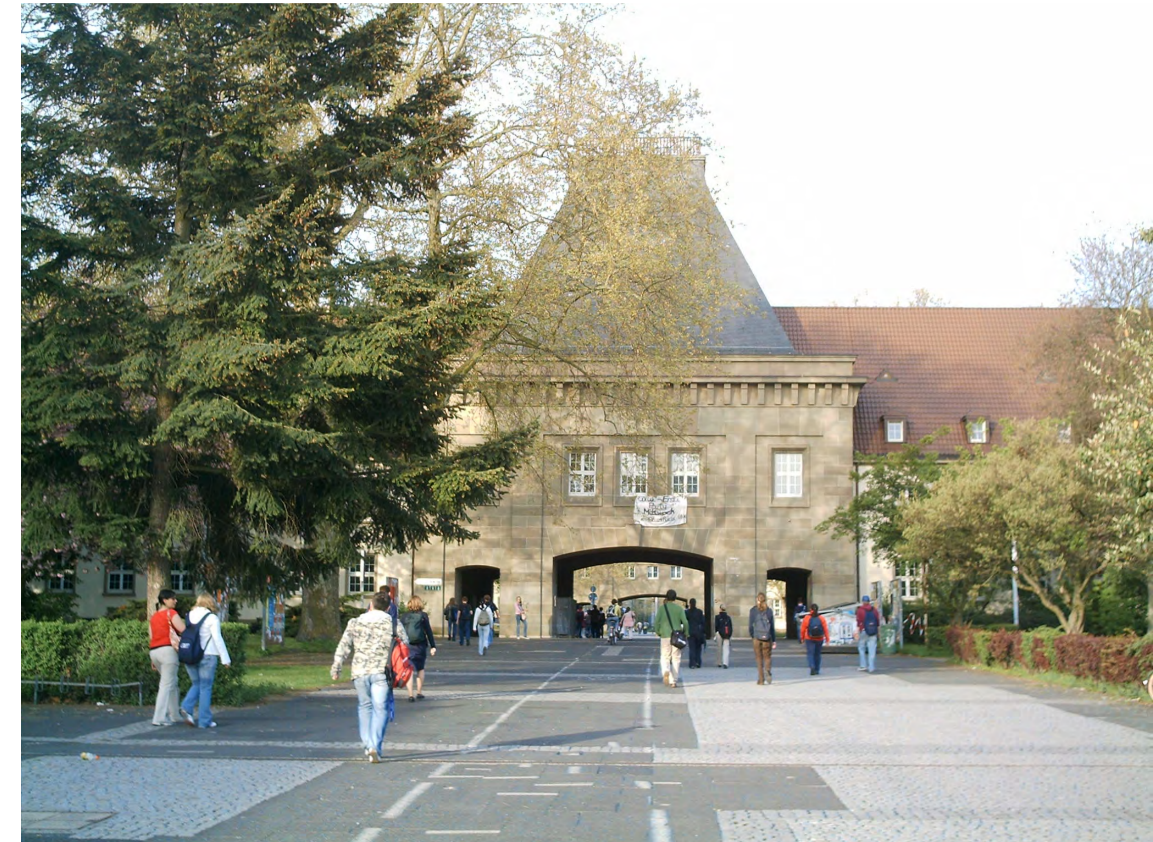
Aktuelle Ansicht des Haupteingangs
